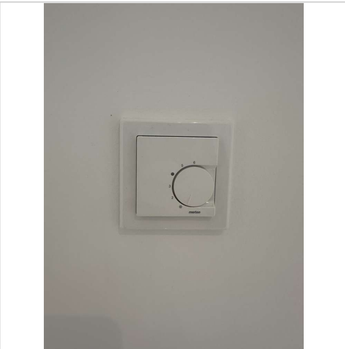
Regler (Fußbodenheizung)
